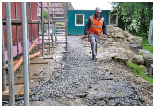
4 L'impiego di calcestruzzo magro ha reso sicura questa via di passaggio temporanea.
