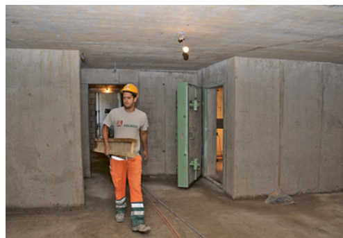
8 Anche la costruzione grezza deve essere illuminata in modo sufficiente.
