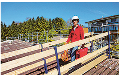
1 Wellplattendach aus Faserzement, mit Laufsteg gesichert.
