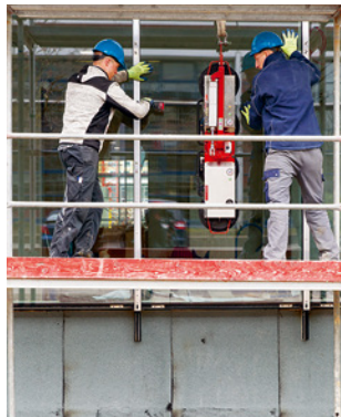
Regel 5 Elemente sicher transportieren
