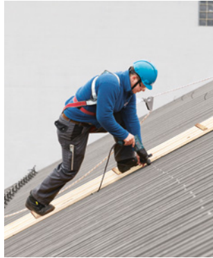
Regel 3 Auf sicheren Dächern arbeiten
