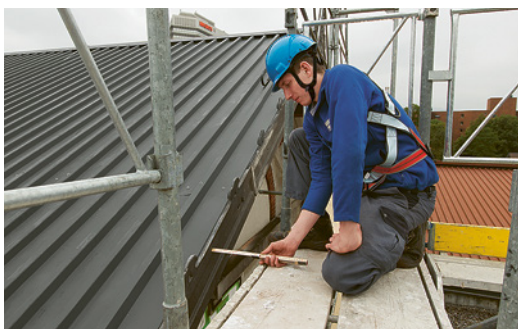
1 Abstand zwischen Gerüst und Fassade: max. 30 cm.
