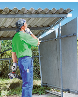
Regel 7 Vor Asbeststaub schützen
