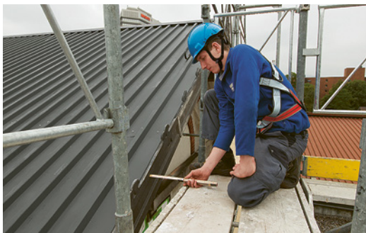
1 Abstand zwischen Gerüst und Fassade: max. 30 cm.
