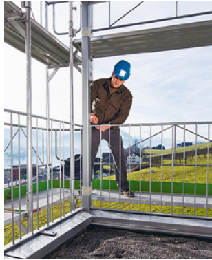
Regel 2 Gerüste täglich kontrollieren
