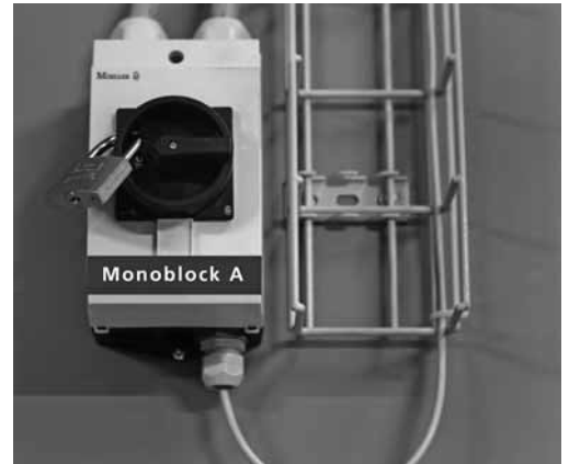
Sicherung der Anlage mit persönlichem Vorhängeschloss.
