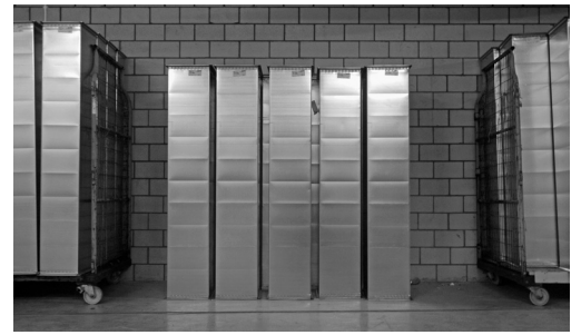
Luftkanäle vor Einbau, geordnet und sauber gelagert.
