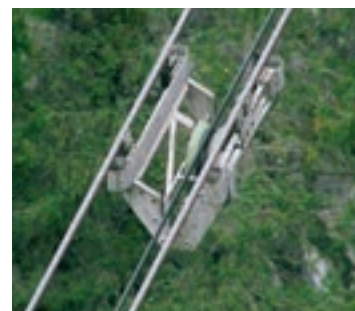
Dopo un guasto alla funivia il drone verifica i carrelli sulla fune di traino.
