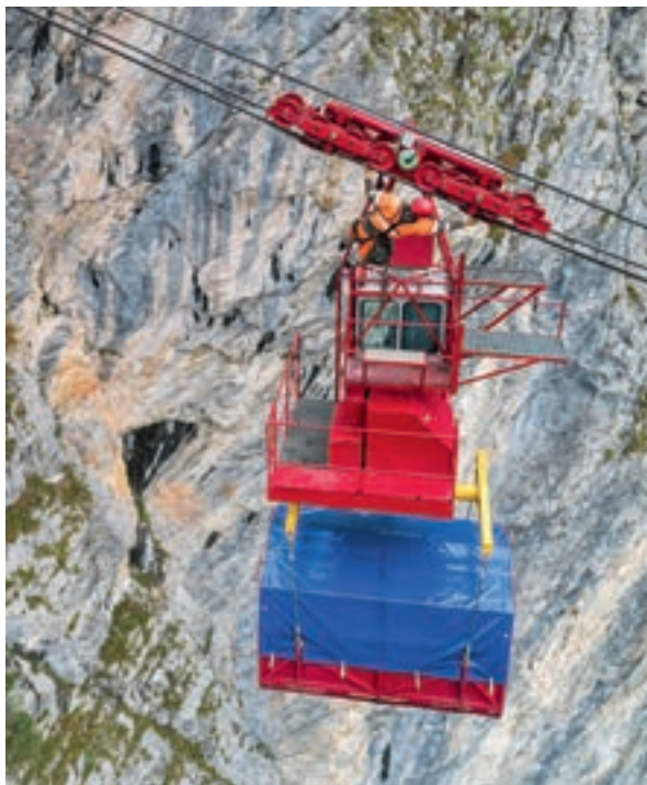
Foto scattata da un drone durante un controllo alla fune portante della funivia Eggi-Äppigen.
