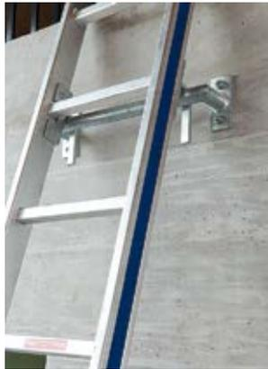
4 Anelli di ancoraggio per scale di appoggio
