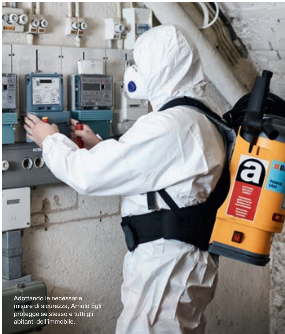
Per proteggersi dalle patologie causate dall'amianto, Arnold Egli indossa una tuta di protezione monouso.
