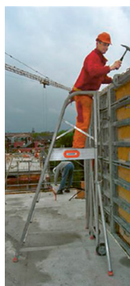
1 Travail sur échelle avec plateforme.
