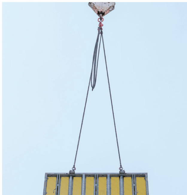
6 Transport par grue: l'élément de coffrage est fixé avec deux pinces d'accrochage (élingue à deux brins).
