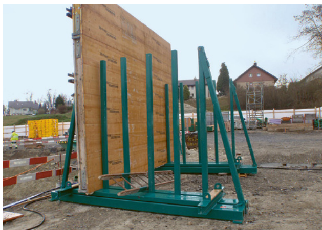
4 Râtelier utilisé pour l'entreposage vertical.
