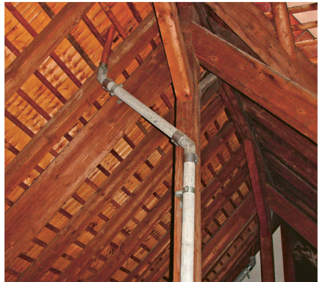
Asbesthaltige Faserzementleitungen
