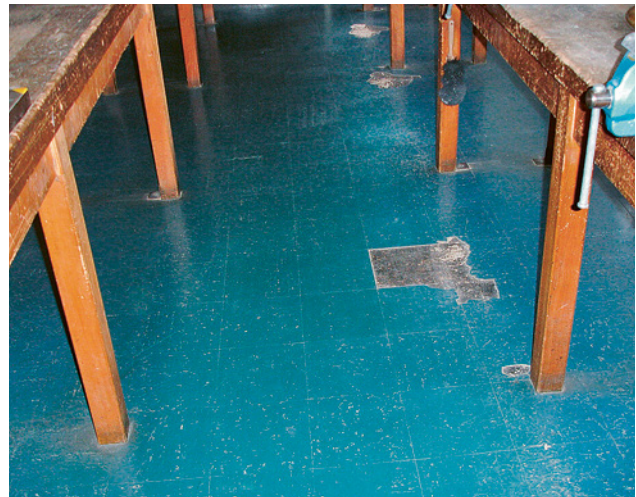
Asbesthaltiger Bodenbelag
