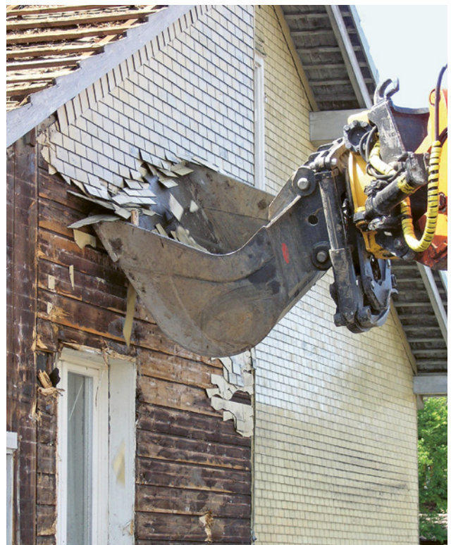
Asbesthaltige Faserzementschindeln
