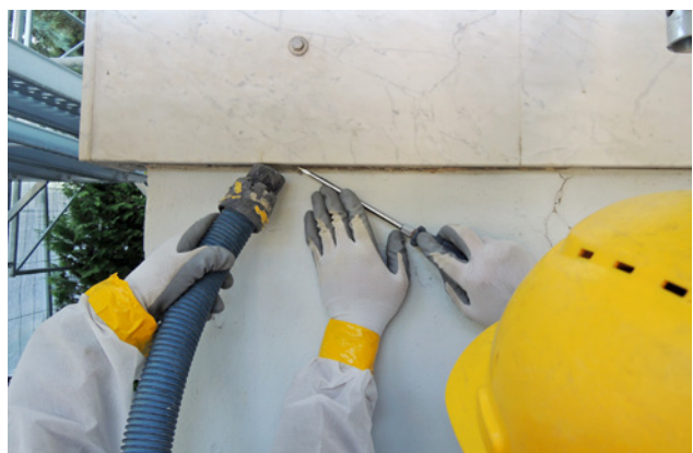
2 Ausbau mit Absaugung an der Quelle.
