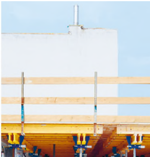
Attuazione sul cantiere
