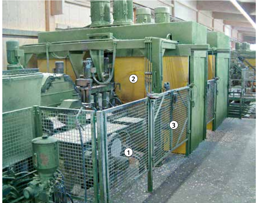
Bild 18: Zuführung erstes Spaneraggregat
