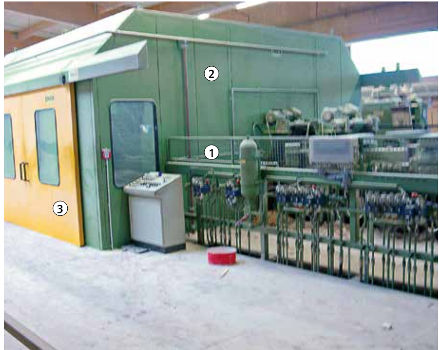
Bild 17: Zuführung erstes Spanneraggregat
