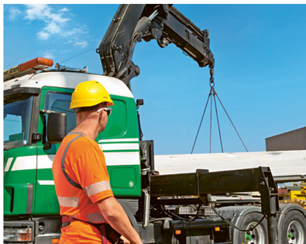
Intervention au moyen d'une grue de chargement
