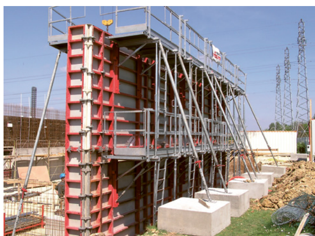
2 Ancoraggio dell'elemento esterno con puntelli di stabilizzazione poggiati su basette in calcestruzzo.
