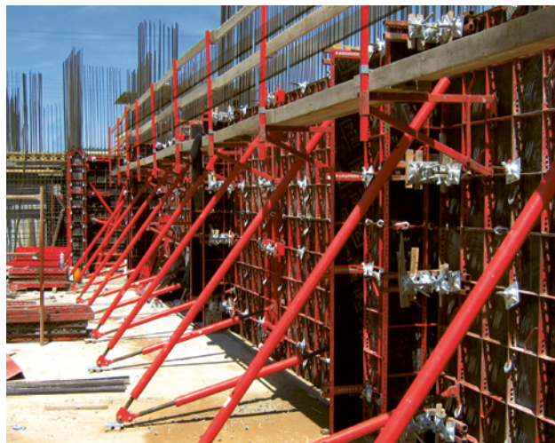
1 Moduli di cassetteria ancorati nel terreno in modo da resistere alle forze di trazione e compressione. Fissaggio in alto e in basso.
