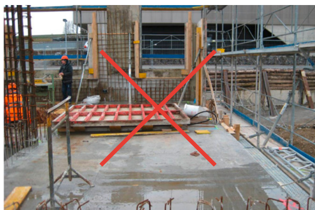
4 Un montatore operante nella parte superiore della casseratura è stato travolto dalla caduta di un modulo. È assolutamente vietato usare i puntelli per solette per sostenere i casseri!
