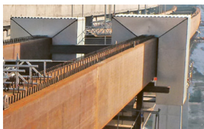
2 Schweisseinhausung. Mit Qualität für Qualität: sichere Zugänge und sichere Arbeitsplätze
