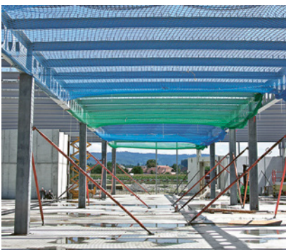
1 Zuerst Kollektivschutzmassnahmen ausschöpfen (z. B. Auffangnetze montieren).
