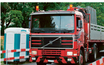
1 Verkehrswege für Personen und Maschinen/Fahrzeuge trennen.
