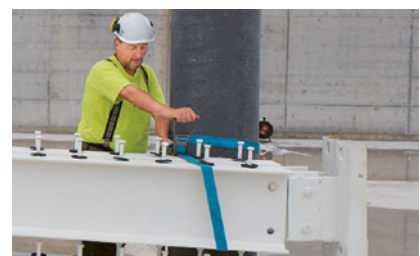
3 Bauteile gegen Umkippen sichern.
