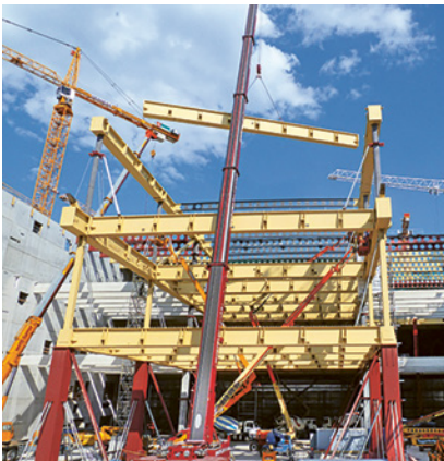
1 Für jede Arbeit das optimale und sichere Arbeitsmittel bereitstellen.
