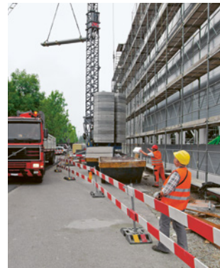
Regel 4 Bauteile sicher abladen und zwischenlagern
