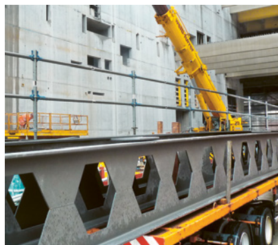
2 Seitenschutz werkseitig oder am Abladeplatz vormontieren.
