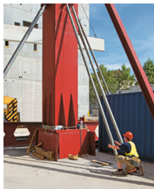
Regel 7 Positionierte Bauteile sichern
