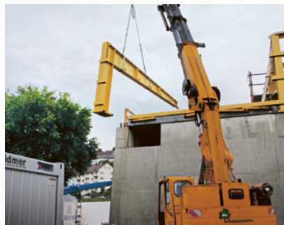
2 Asymmetrische Lasten korrekt anschlagen.
