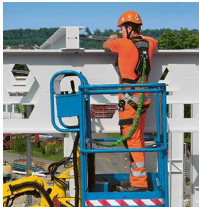
2 Montagearbeiten mit Hubarbeitsbühnen: effizient, sicher und ergonomisch.
