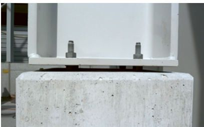
1 Korrekt gesicherte Fussplatte mit total 4 Ankern
