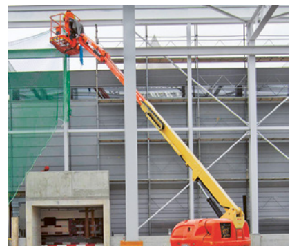
3 Hubarbeitsbühnen einsetzen, statt mit Anseilschutz arbeiten.
