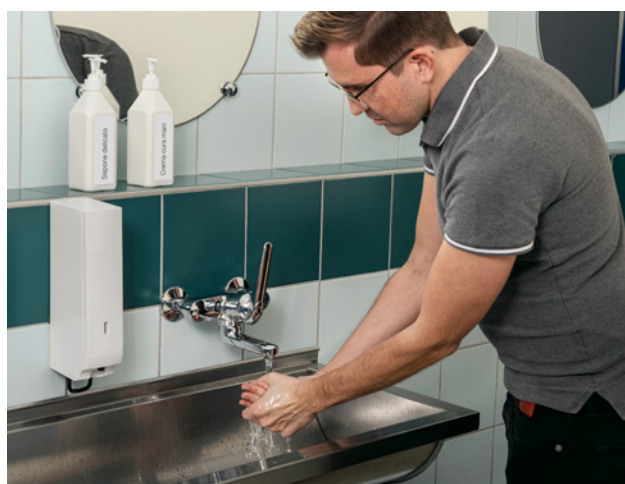
15 Stazione di lavaggio con diversi detergenti in funzione del tipo di sporco.
