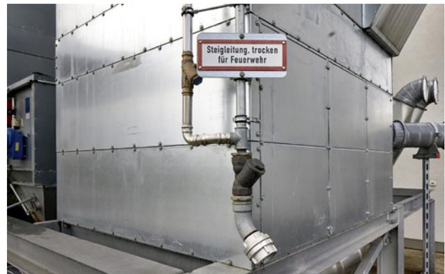
2 Trockenlöscheinrichtung mit Storz Kupplung für Anschluss Feuerwehrschauch (Quelle: Türfabrik Brunegg AG).
