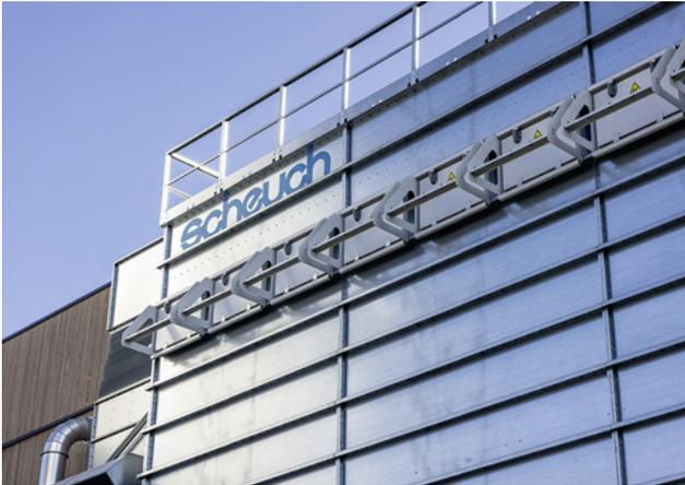
5 Druckentlastung mit Klappen (Quelle: Scheuch Ligno GmbH)
