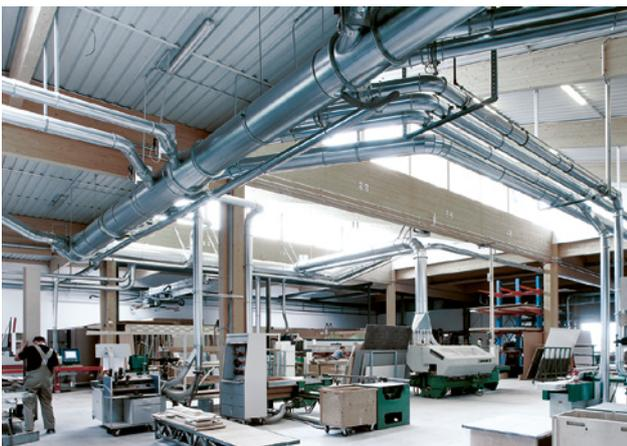
16 Rohrleitungen zwischen den Holzbearbeitungsmaschinen, Absauganlage und Silo. (Quelle: Scheuch Ligno GmbH)
