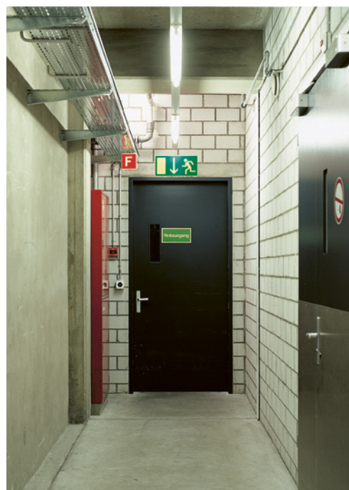
3 Via di fuga delimitata da una porta apribile nel senso dell'esodo
