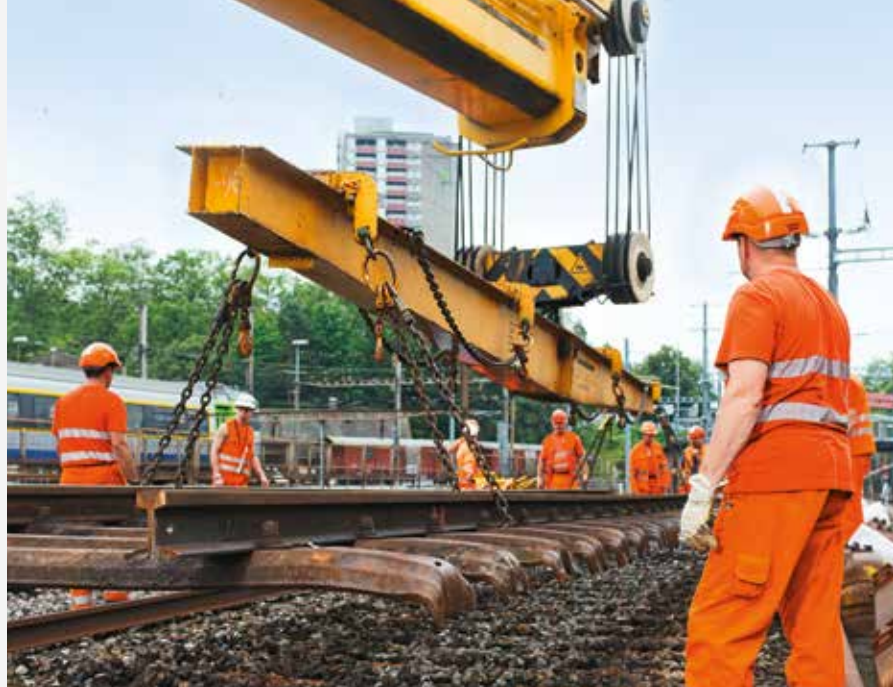
Baugruppe im Gleisbau beim Anheben eines Gleiselements.
