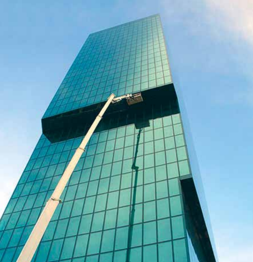
Arbeitsbühnen im Einsatz bei der Reinigung von Glasfassaden hoher Gebäude.
