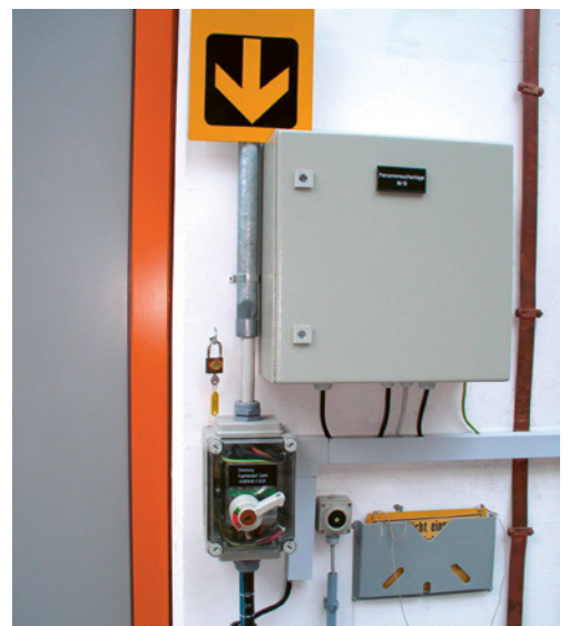
5 Interrupteur pouvant être verrouillé en position déclenchée, afin d'éviter toute mise en marche intempestive du pont roulant.
