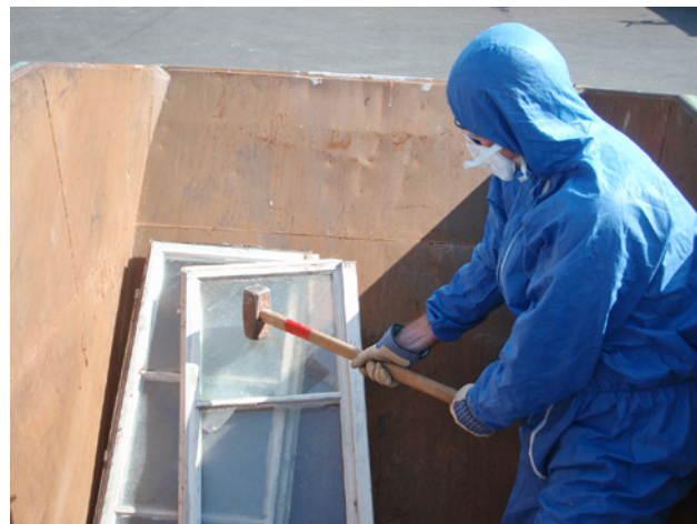
1 Rimozione del vetro con una mazza
