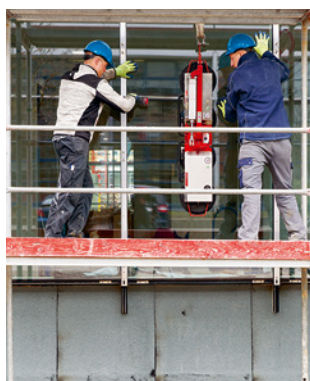
Regola 5 Trasportare gli elementi in sicurezza
