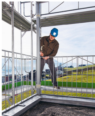
Regola 2 Controllare ogni giorno i ponteggi
