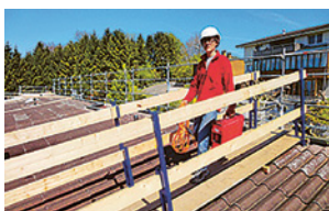
1 Tetto in lastre ondulate di fibrocemento protetto da una passerella
