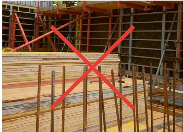
1 Ungesicherte Anschlussbewehrungseisen
