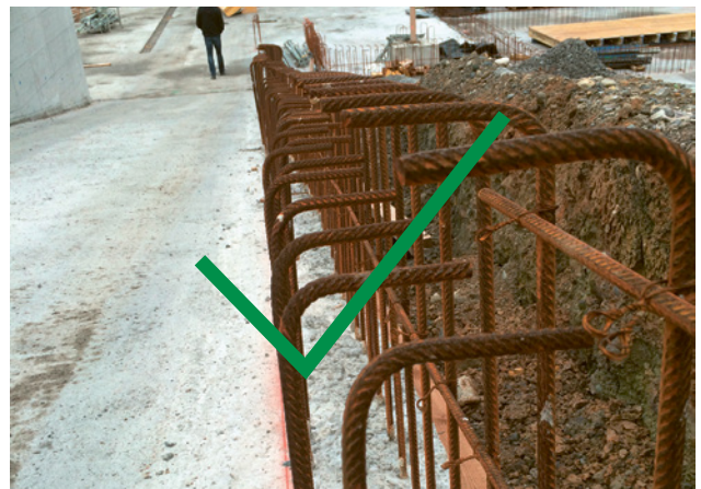
2 Anschlussbewehrungseisen mit Winkeln ausgebildet
