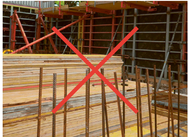
1 Ungesicherte Anschlussbewehrungseisen
