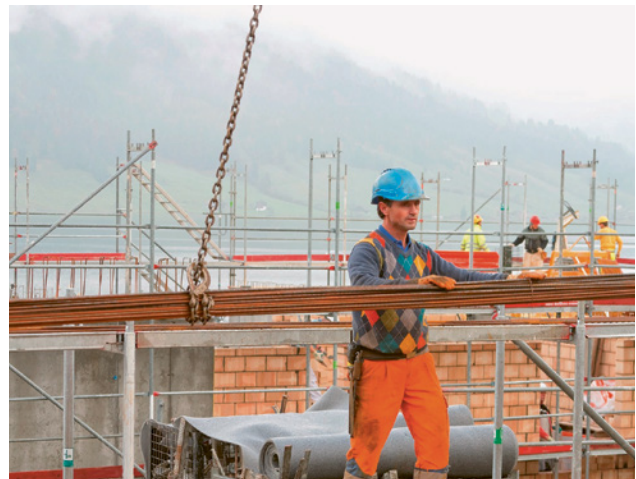
4 Krantransport eines Bewehrungsseisenbündels
