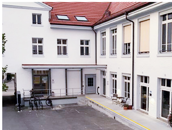
La cour intérieure a également été adaptée aux prescriptions actuelles et sert désormais de zone de rencontre.
