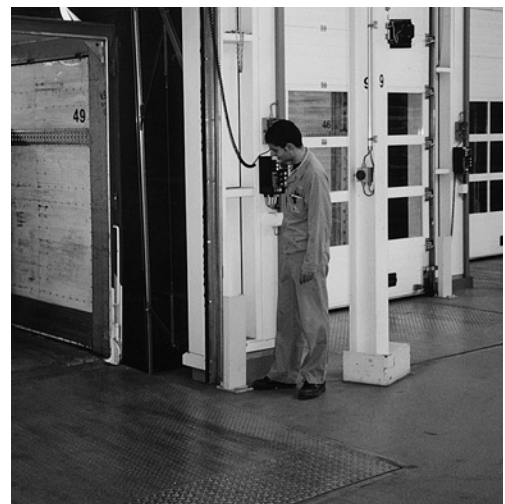
3 Cet opérateur dispose d'une bonne visibilité pour la mise en place de la rampe.
