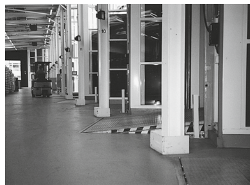
4 Les rampes relevées peuvent occasionner des chutes de plain-pied. Ce danger est signalé par les rayures latérales jaunes et noires.
