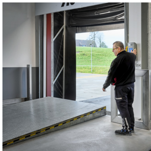
3 Une bonne visibilité est indispensable pour pouvoir ajuster correctement la rampe.
