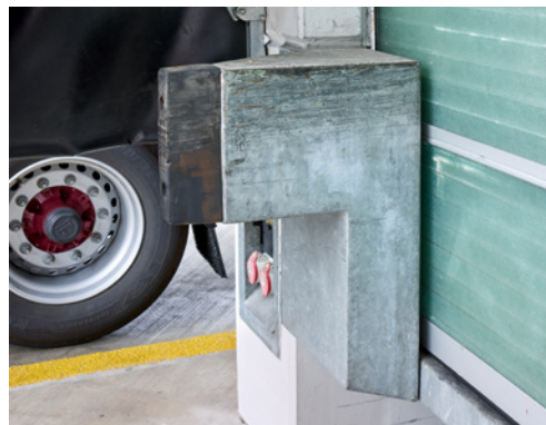
1 Risque de coincement! La distance «e» entre le mur au-dessus du quai et le camion doit être d'au moins 0,4 m.
