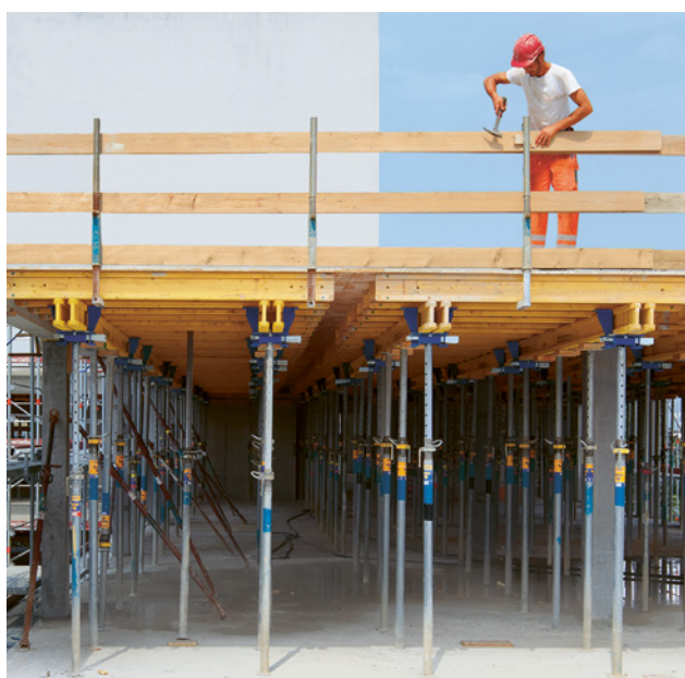
3 Protezione laterale con morsetti
