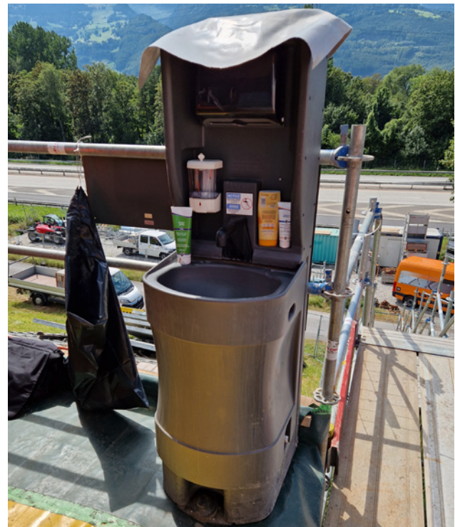
4 Waschmöglichkeit für Hände, Arme und Gesicht ausserhalb der Sanierungszone
