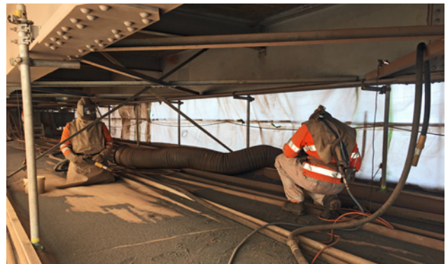
1 Beispiel Strahlarbeiten: Sanierung einer Stahlbrücke (Schwarzbereich)
