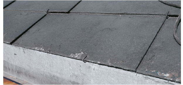
Ardoises de toitures
