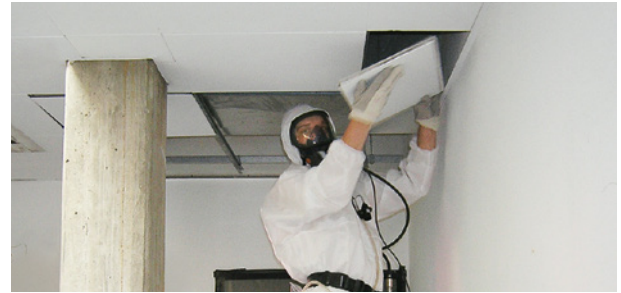
Enlèvement par une entreprise en désamiantage reconnue
