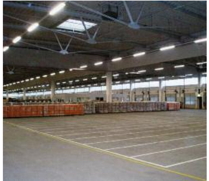
Fig. 3: problema del numero e della visibilità delle uscite di emergenza in una centrale di distribuzione di prodotti alimentari.
