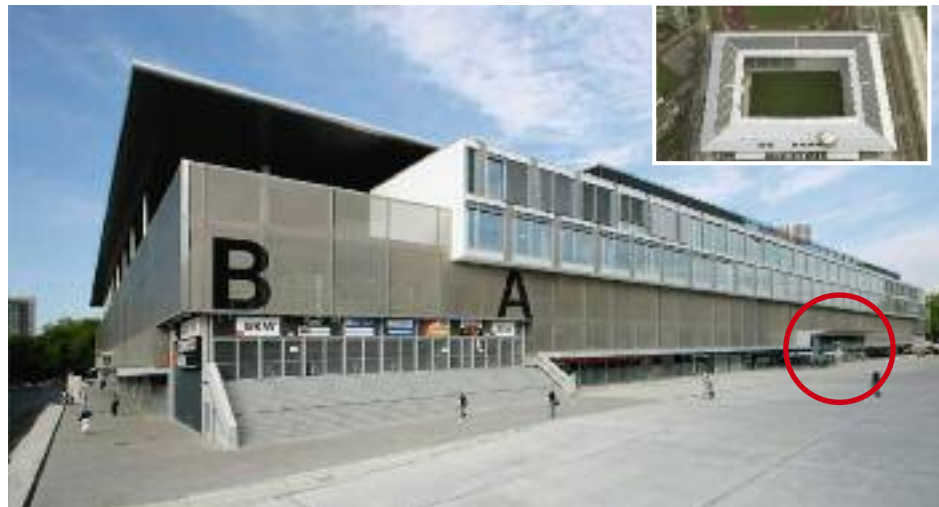
Fig. 1: Stade de Suisse a Berna. Il centro commerciale occupa una parte del piano interrato. Nel cerchio rosso: ingresso al centro commerciale.
