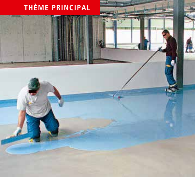
Travail avec une résine époxy dans le bâtiment.
