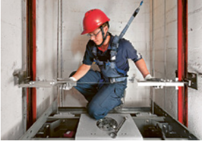
1 Tetto della cabina
