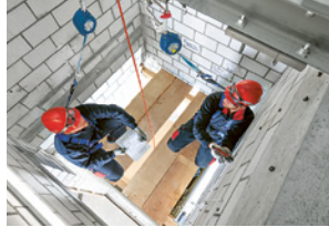
2 Ponteggio per il vano ascensore
