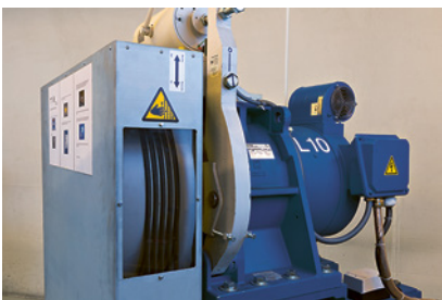
1 Puleggia motrice con cuffia di protezione
