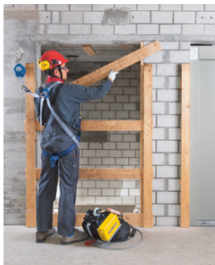
Regola 3 Adottare adeguate misure anticaduta.
