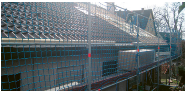
3 Parete di protezione da copritetto con rete di sicurezza correttamente montata.
