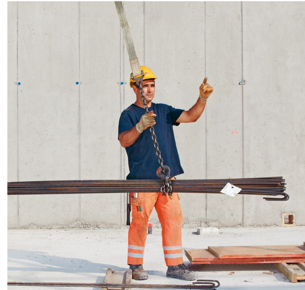
Regel 3: Wir bedienen Krane vorschriftsgemäss und schlagen Lasten sicher an.
