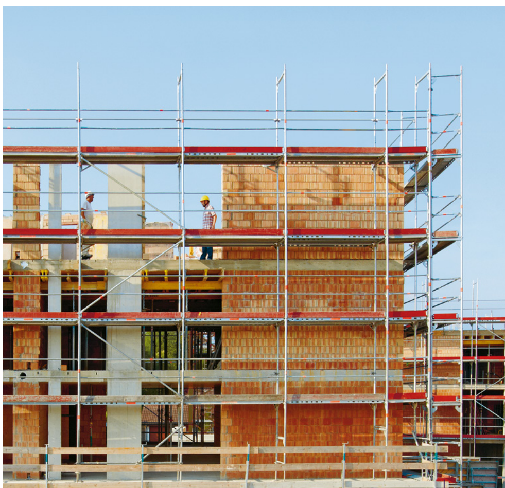
Regel 4: Wir arbeiten ab einer Absturzhöhe von 3 m nur mit Fassadengerüst.
