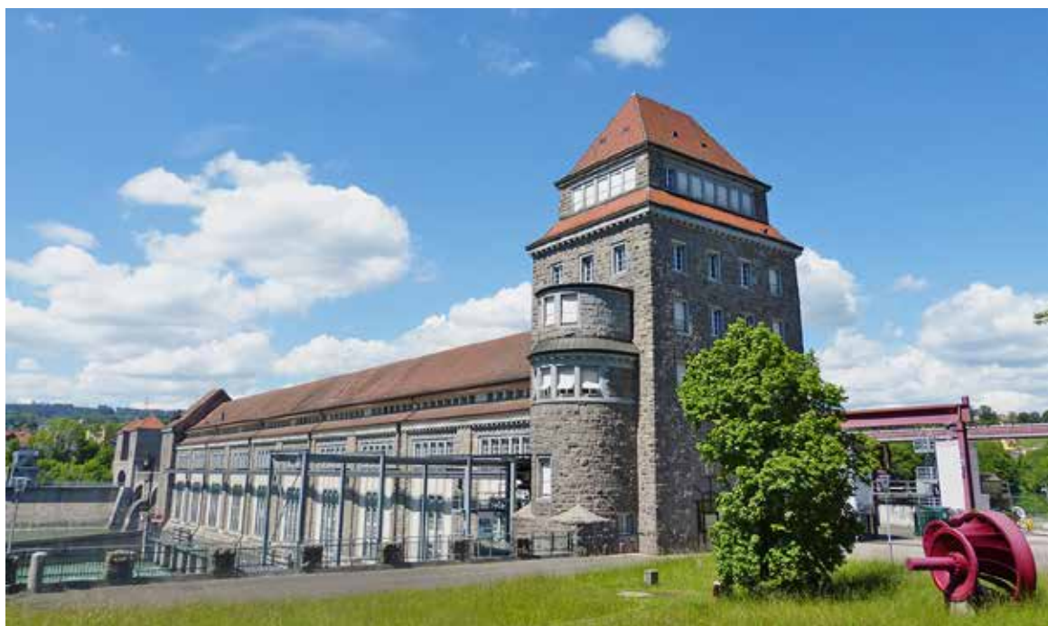
La centrale idroelettrica di Laufenburg è situata al confine tra la Germania e la Svizzera.
