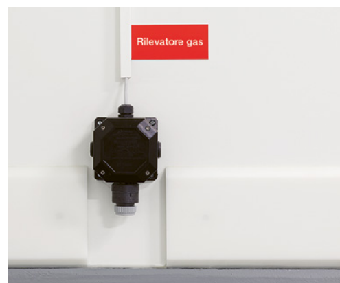
7 Impianto di rilevazione del gas
