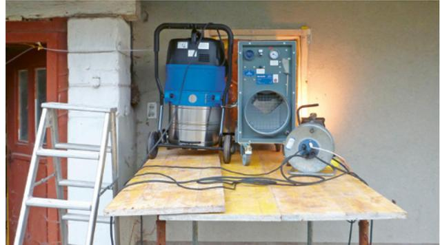
3 Unterdruckhaltegerät in einem Fenster eingebaut und abgedichtet. Der Schlauch des Staubsaugers wird durch die Abdichtung geführt.
