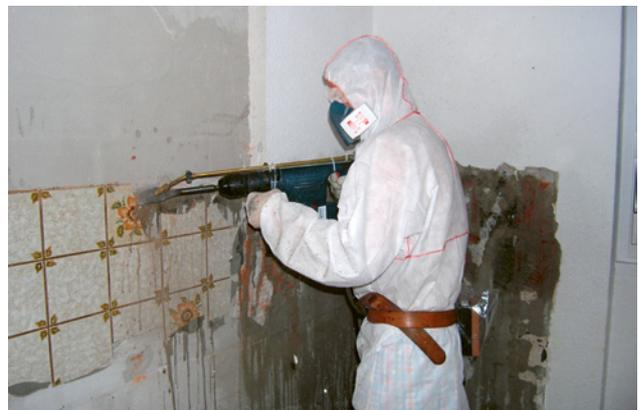
1 Platten mit asbesthaltigem Kleber werden mit einem Spitzhammer mit Wasserbedüsung entfernt.
