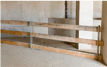
1 Grosse Bodenöffnung mit dreiteiligem Seitenschutz
