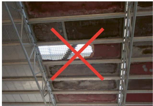
Figura 1 La presenza di macchie nere estese indica un principio di putrefazione. Il piano deve essere controllato.
