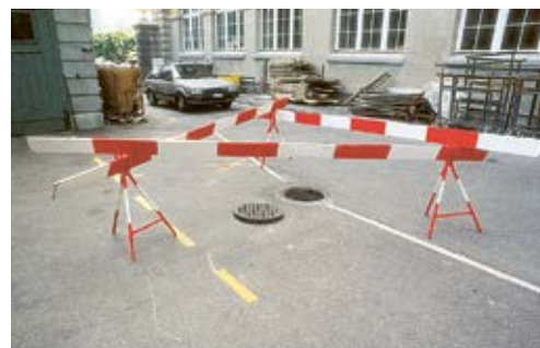
10 Clôture autour de l'ouverture d'un puits.
