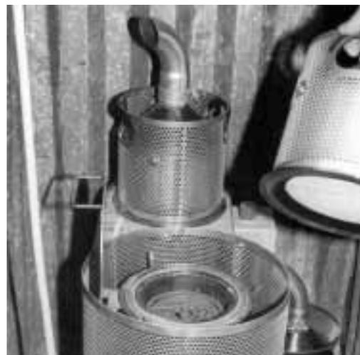
Figure 2: centrale de combustion pour la régénération des filtres interchangeables.
