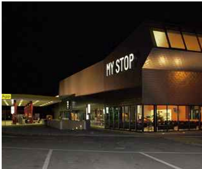
Restoroute du Saint-Gothard A2, Uri
