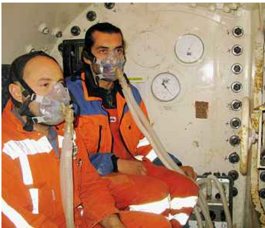
Décompression avec oxygène: à partir d'une surpression de 1 bar, la décompression est effectuée au moyen d'un masque à oxygène pur. Photo: Arbeitsgemeinschaft Hochwasserentlastungsstollen Thun AHT
