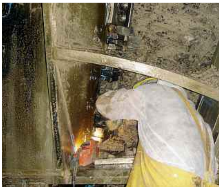
Changement d'un outil sur la lame circulaire: dur travail dans le milieu hyperbare et le climat moite de la chambre de travail d'un tunnelier. Photo: Arbeitsgemeinschaft Hochwasserentlastungsstollen Thun AHT
