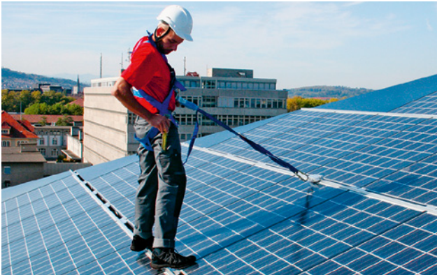
13 Dispositivo di ancoraggio integrato nell'impianto solare
