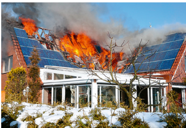
20 Incendio in un edificio con impianto solare
