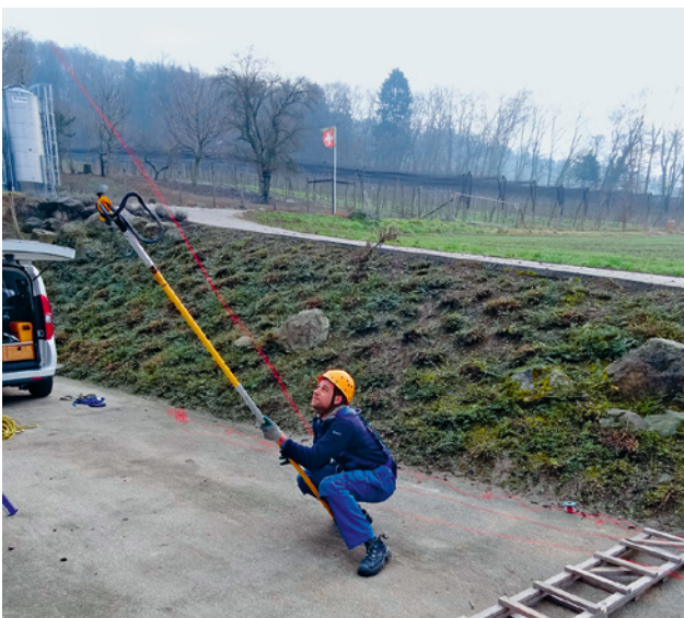
14 Sistema di lancio con fionda industriale
