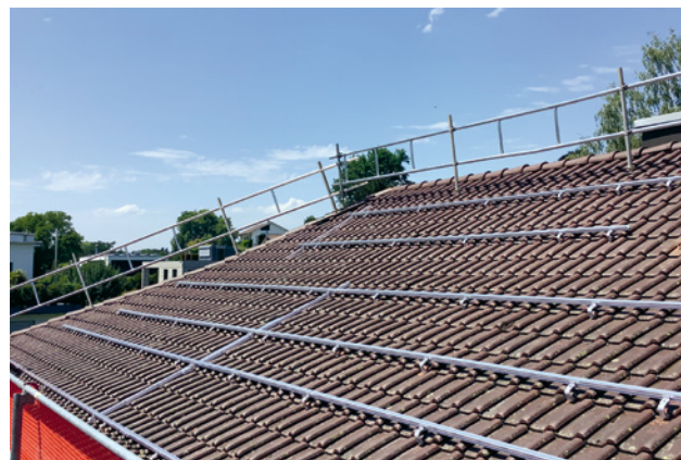
3 Una protezione laterale sul colmo evita le cadute dalla falda del tetto su cui non si lavora.
