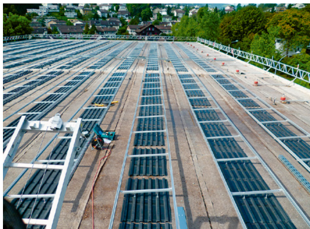
2 Montaggio di un impianto solare con protezione laterale temporanea al bordo del tetto
