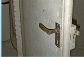
Brandschutztüre mit Asbestzement
