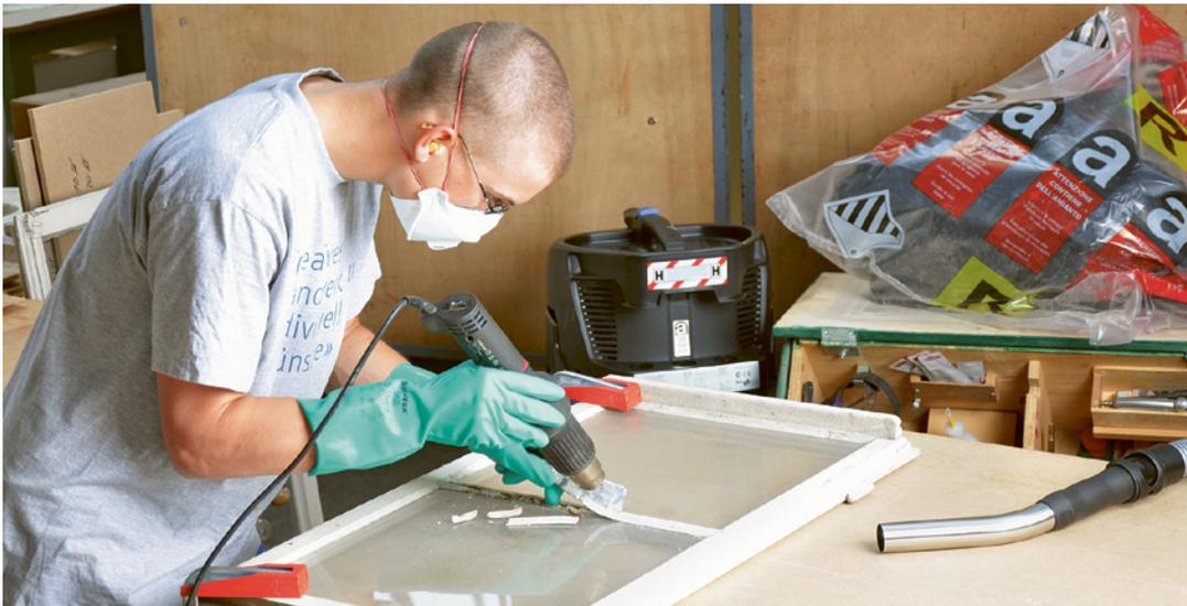
Entfernen von asbesthaltigem Fensterkitt mit Heissluftföhn.
