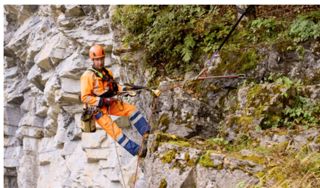
2 Redondance du système grâce à un ancrage indépendant du système de travail et du système de sécurité
