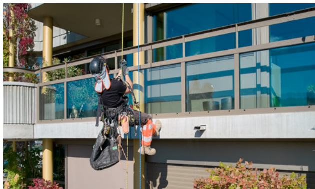
1 Les travaux sur cordes sont toujours exécutés avec une corde de travail et une corde de sécurité.
