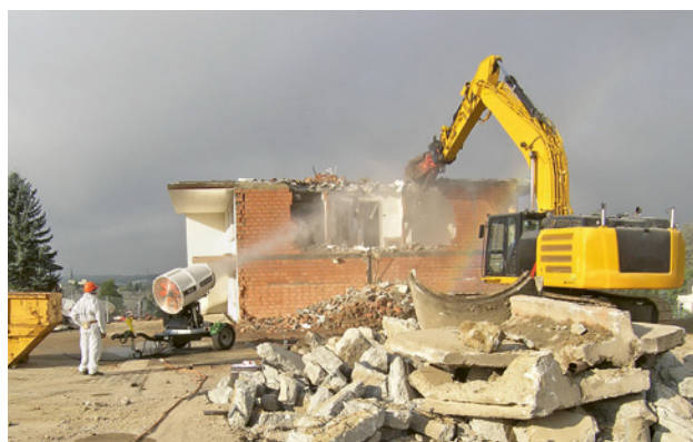
Demolizione con escavatore idraulico
